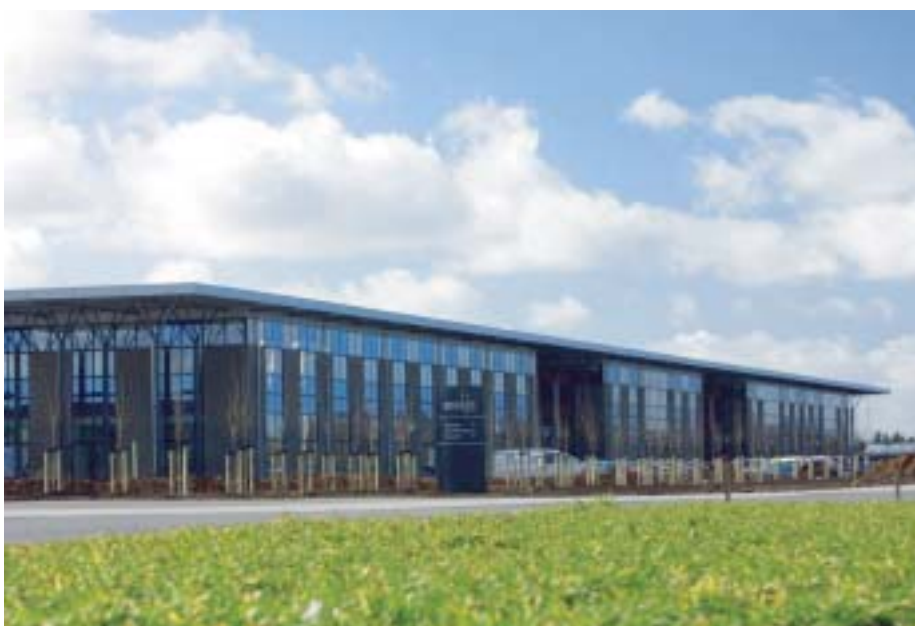
Den nye administration i Brande blev taget i brug i begyndelsen af året, og sommeren 2002 forventes den nye vingefabrik i Aalborg ligeledes færdig.
