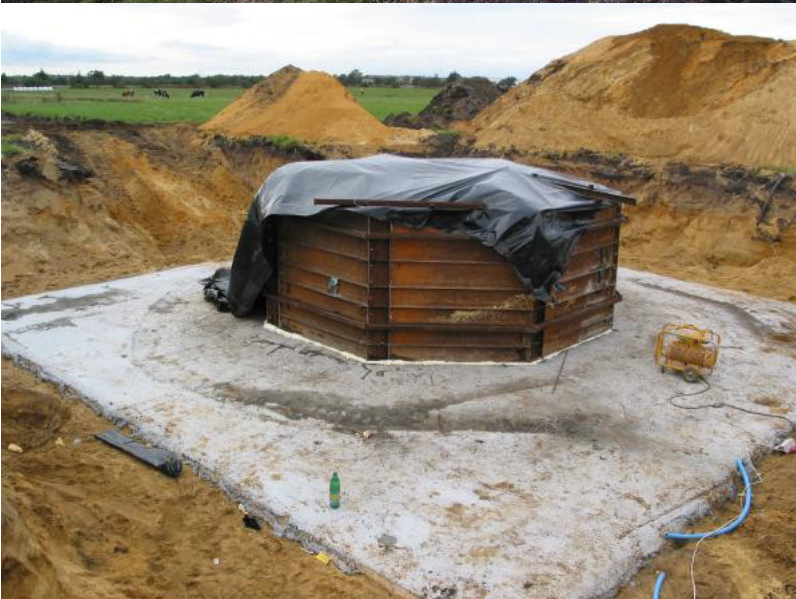
Det netop afsluttede støbearbejde.
